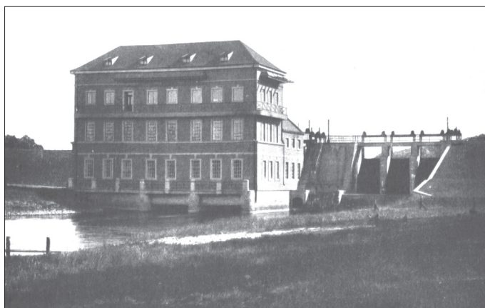
Elektrownia Wodna Rejowiec w Smolęcynie (Wasserkraftwerk Schmalenthin). Geschäftsbericht der Ueberlandzentrale Pommern A.G. Stettin für die Zeit vom 1. Januar 1927 bis 31. Dezember 1927 , Stettin 1928, wklejka
