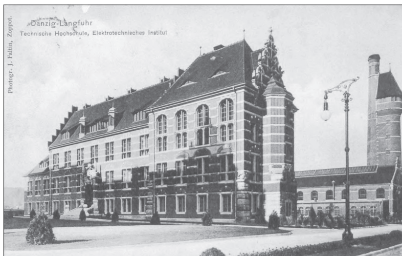
Budynek Instytutu Elektrotechnicznego, na drugim planie Laboratorium Maszynowe
