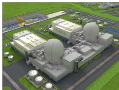
APR1400/EU-APR: reaktor wodno-ciśnieniowy, moc brutto: 1455 MWe; KHNP – Korea
