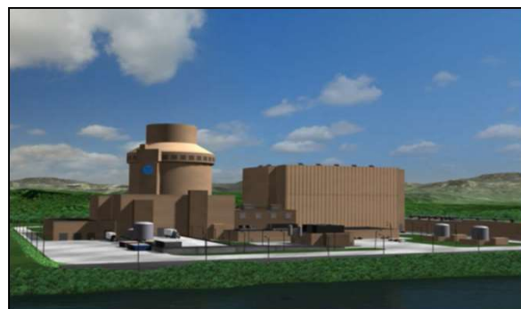
AP1000: reaktor wodno-ciśnieniowy, moc brutto: 1250 MWe; Westinghouse – Brookfield Asset Management Inc - USA/Kanada
