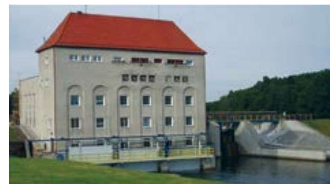
Dobrzyca – elektrownia wodna na Pilawie
