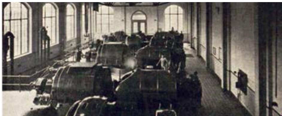
Maszynownia Elektrowni Garbary w Poznaniu
