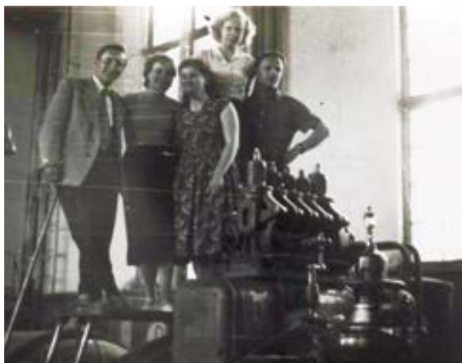
Generator Elektrowni w Pile, Barbara Lotek, Jadwiga Wołoch, Krystyna Łopatko i Stanisław Grabowski, 1957 rok
