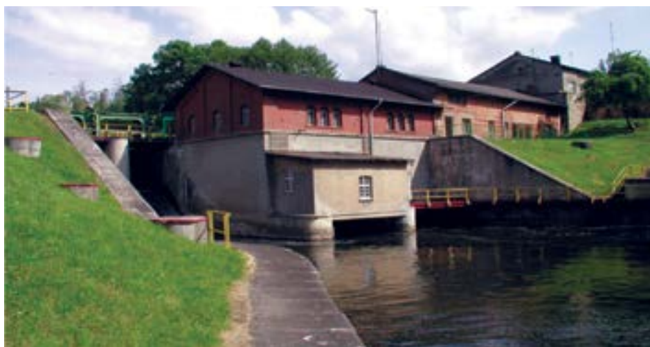
Kamienna - elektrownia wodna
