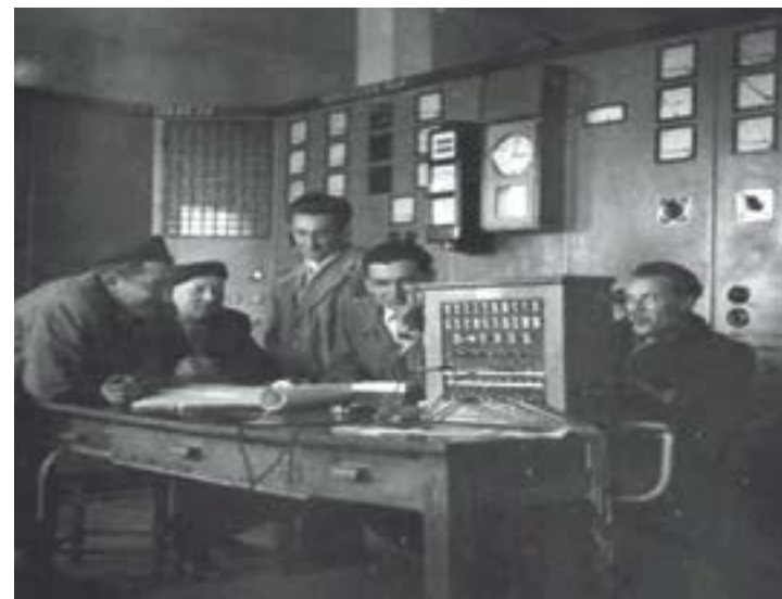
Nastawnia w elektrowni pileckiej
