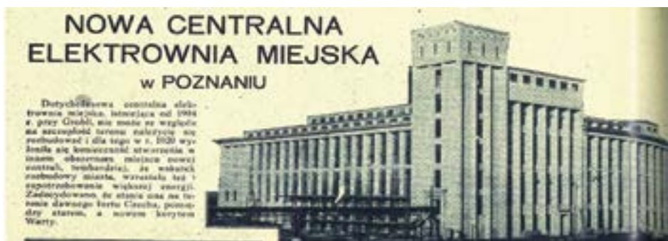
Na budowę tej elektrowni miasto Poznań wydało 600 tys. marek
